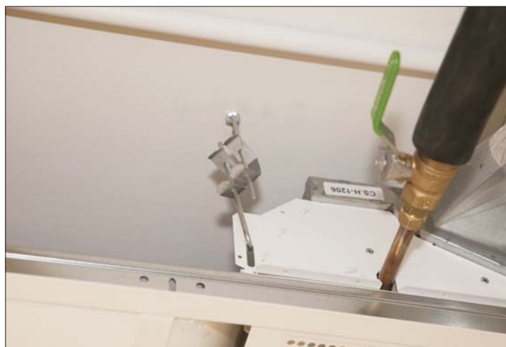
Monterad med undertaxskrok.
